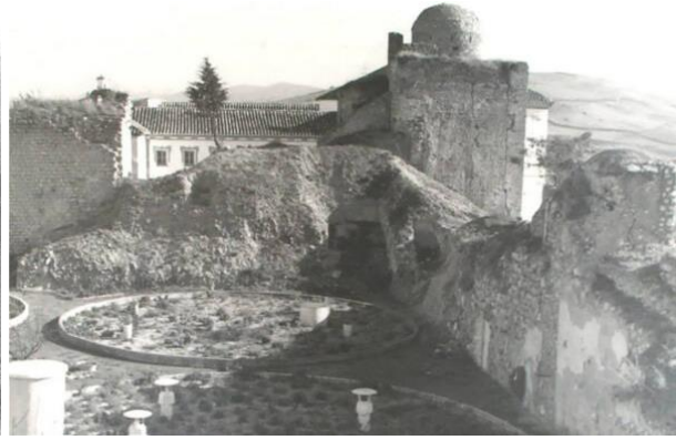
Şekil 5. Su depolarının eklenmesi sonrası kale (URL8)
