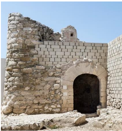
Şekil 10. Özgün ve çağdaş malzemenin farkı (URL10)
