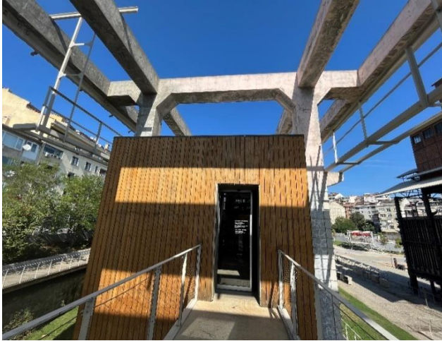
Resim 23,24. Alanda endüstriyel kimliği ön planda olan korunmuş fırın yapısı ve içine kütle yerleştirilen kok nakil tesisi (Arşivimden, 2023)
