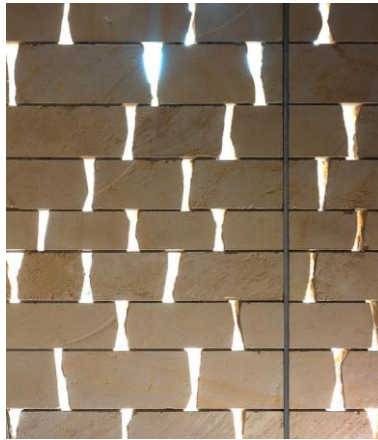
Şekil 11. Kumtaşı blokların kendine özgü örüm şekli (URL9)
