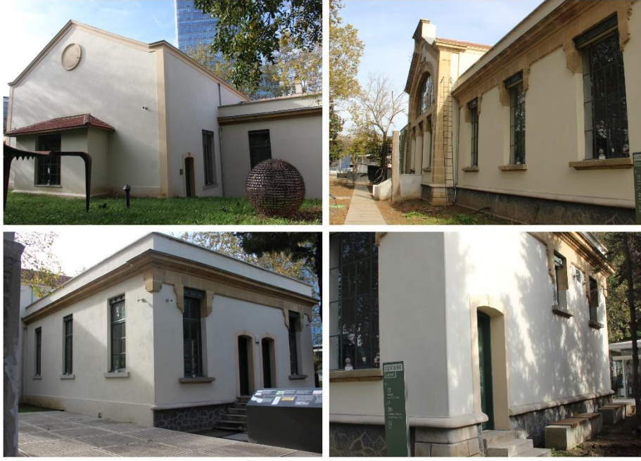
Şekil 2. Cendere Sanat Müzesi Ana Bina Dış Cephe Görünüşleri
